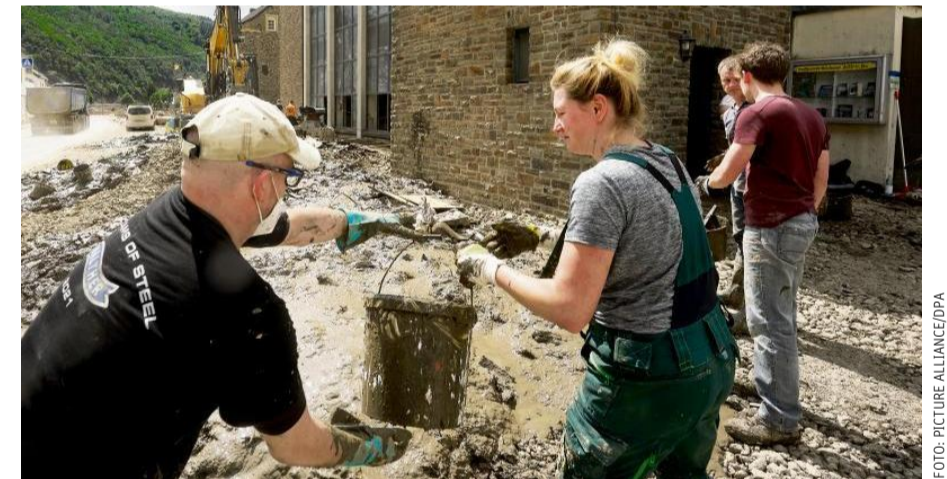
Ehrenamtliche helfen bei der Beseitigung der Schäden der Flutkatastrophe
